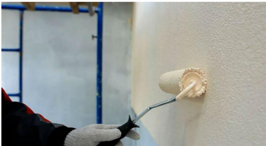
Рис. 19. Нанесение краски на поверхность фасада
