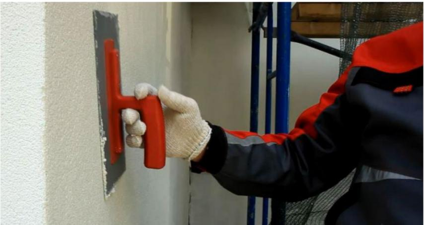
Рис. 18. Нанесение декоративного слоя штукатурки
