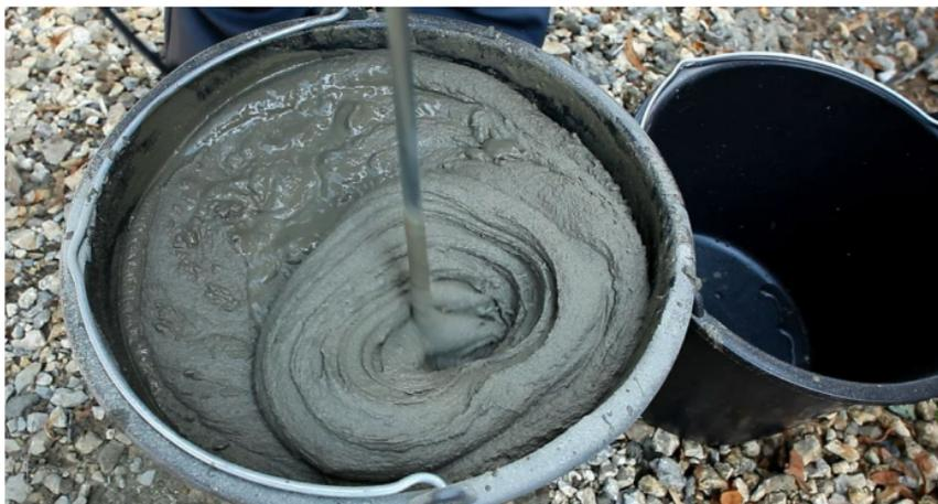
Рис. 3. Замешивание клея для приклейки теплоизоляции
